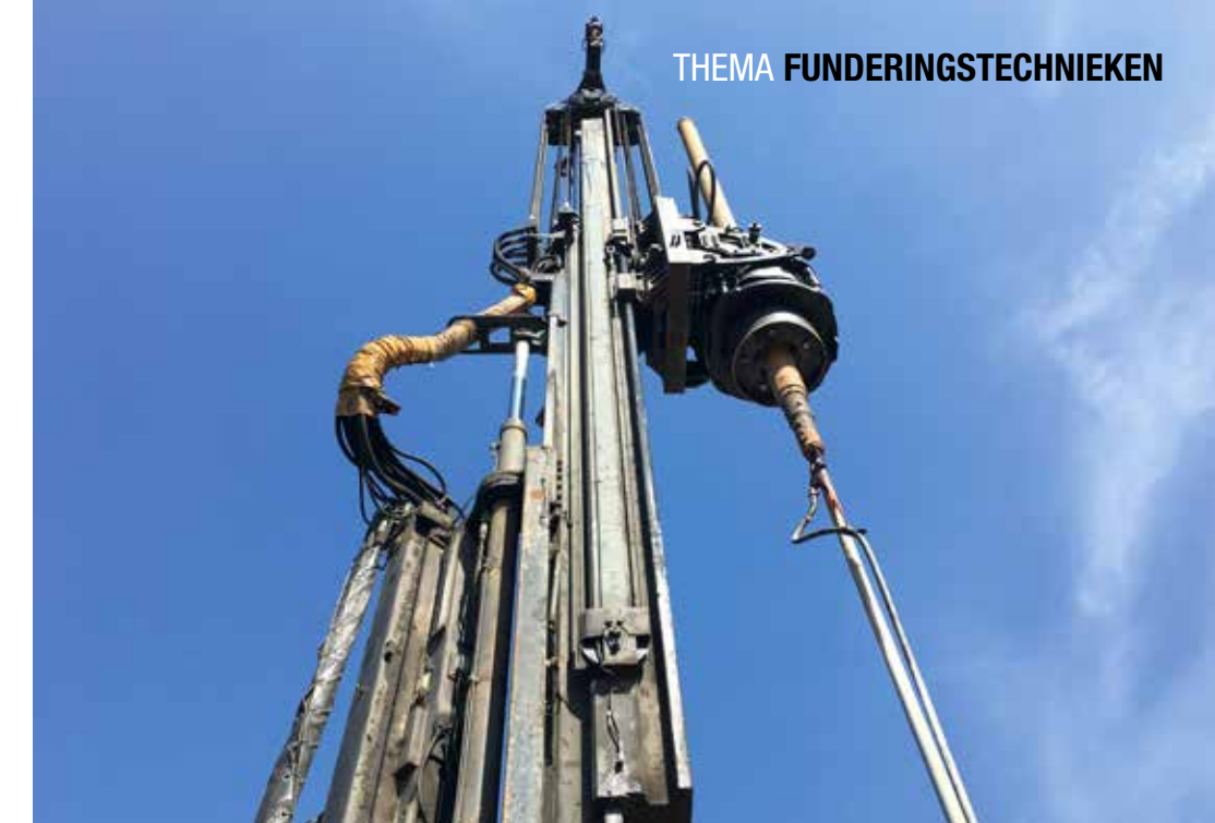
Bentonietinjecties zijn een specialiteit van Van Schie en worden door hen veel toegepast. Ook bijvoorbeeld voor het vullen van gaten of sleuven in dijken.
