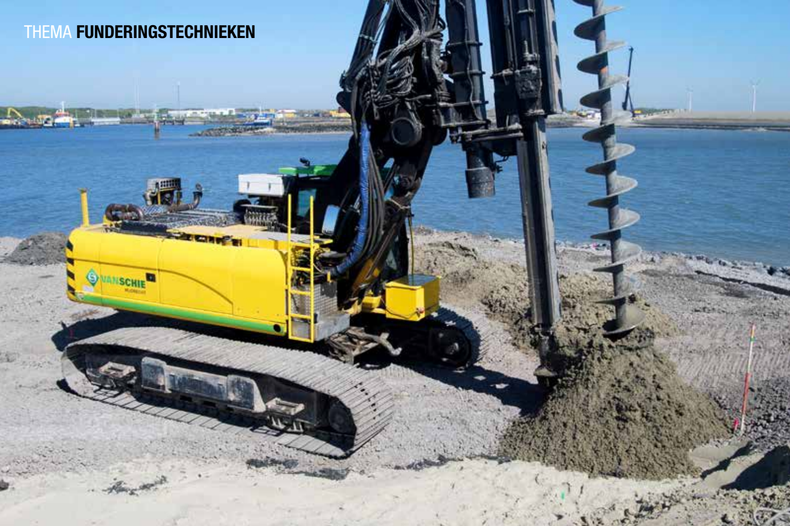
Op Neeltje Jans heeft Van Schie een bijdrage geleverd aan de fundaties van een windmolenpark. Voor dit bewuste werk moest een boorkraan worden ingezet die onder een schoorstand van 14 graden kon voorboren.
