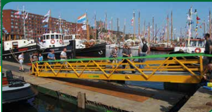
Vier tijdelijke aanlegsteigers, elk 85 meter lang, bestaande uit 210 plaatpontons. Ze vormden de ligplaatsen voor het Varend Erfgoed dat met veel liefde in stand wordt gehouden: Antieke sleepboten, binnenvaartschepen, oude zeilboten, platbodems, vissersboten, etc.
