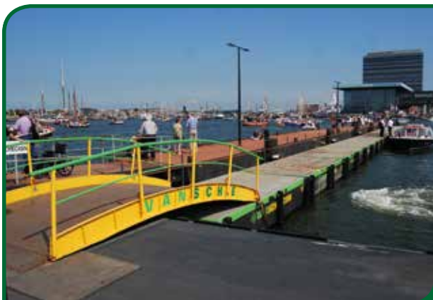
Aanlegsteigers voor rondvaartboten. Deze tijdelijke steigers waren bestemd voor de rondvaartboten die met toeristen langs de windjammers over het IJ voeren.
