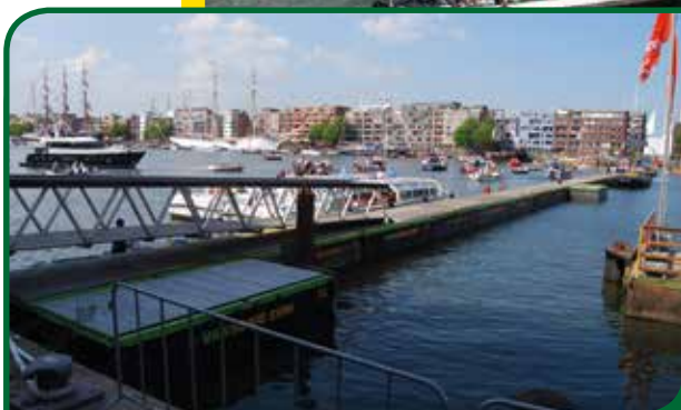
Afsluiting dwars over de IJ-haven, gevormd door 40 Uniflote pontons. Dit was om het gedeelte bestemd voor het 'Varend Erfgoed' af te scheiden van het gedeelte waar toeschouwers vrij mogen varen, dus waar de grote windjammers lagen.
